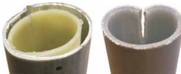
Разрушение трубы при некачественном клее (разрыв при 68 бар)
