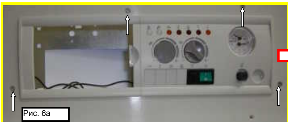
Рис. 6а (ALTAIR – DRAGO): Открутить 4 винта и снять пластмассовую панель, отдалив ее на несколько сантиметров ("а").
