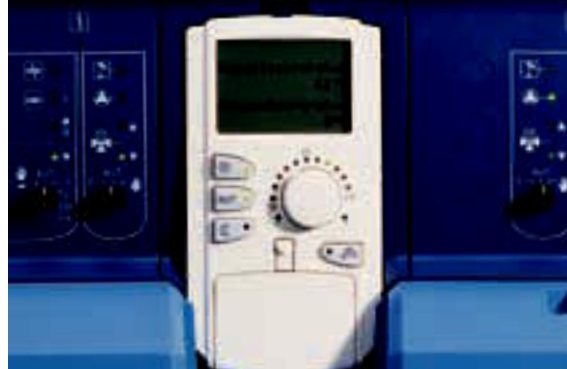
Блок управления MEC2 системы управления Logamatic 4000
